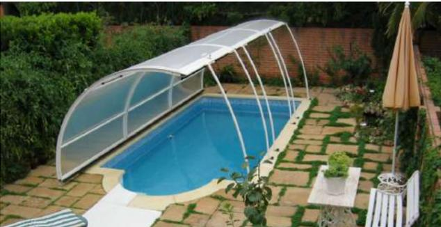
Cubierta baja de moderno diseño aerodinámico, basada en un sistema de módulos independientes elevables que permiten acceder lateralmente a la piscina.
